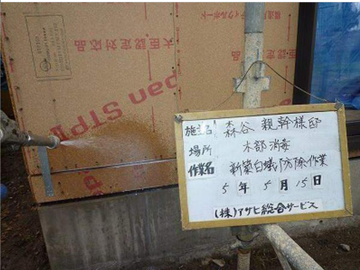
1-7口地面からの高さが1m以内の外壁の枠組の防腐・防蟻措置を現場で塗布・吹付をする。(2/4)
