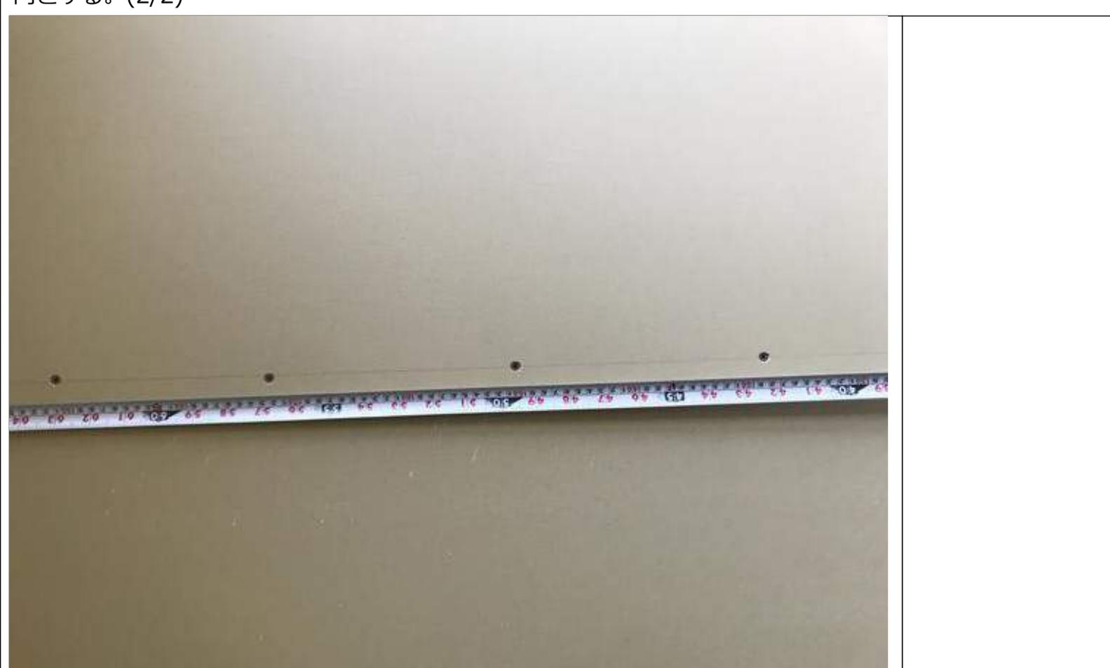
1-16 壁張りに用いるせっこうボードは、床面からの湿気により強度が低下しないように床面から13mm程度離して打ち付ける
