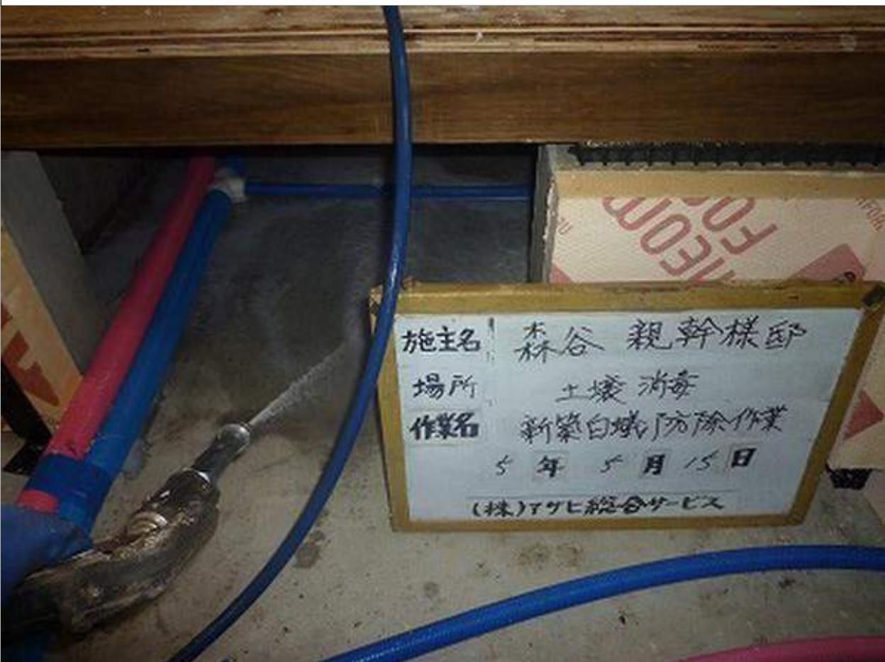
1-7口地面からの高さが1m以内の外壁の枠組の防腐・防蟻措置を現場で塗布・吹付をする。(4/4)
