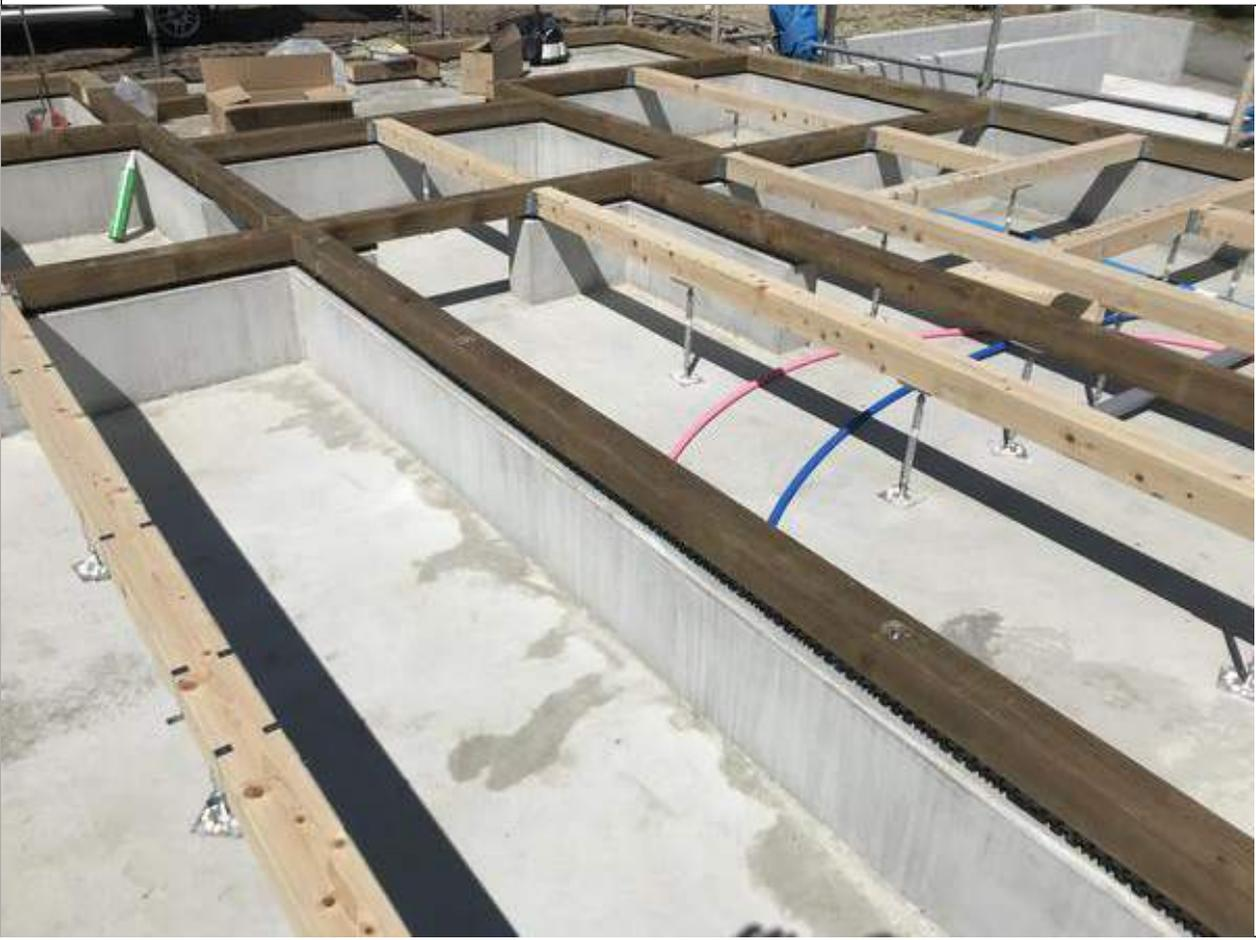
1-6口土台の防腐・防蟻処理材を用いる。（土台に接する外壁の下端には、水切りを設ける）
