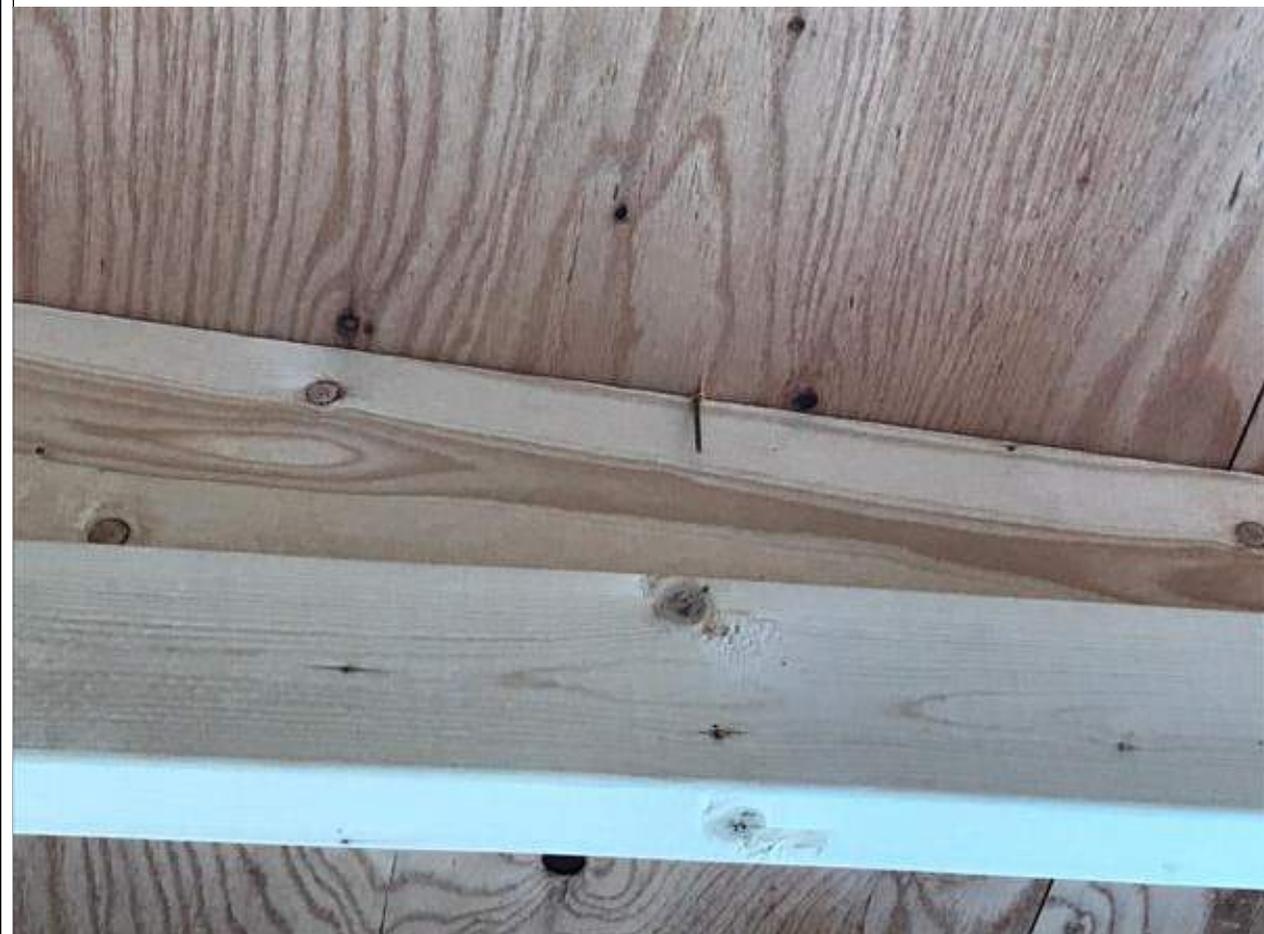
1-19 内側から見て屋根に外し釘がないか確認する。釘は合板端部より10～15mm離す。(2/2)
