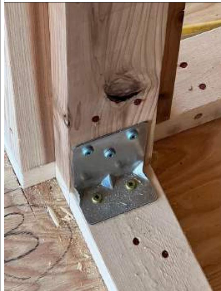
1-13口接合金物の種類・施工位置が図面通りか確認する。(2/2)
