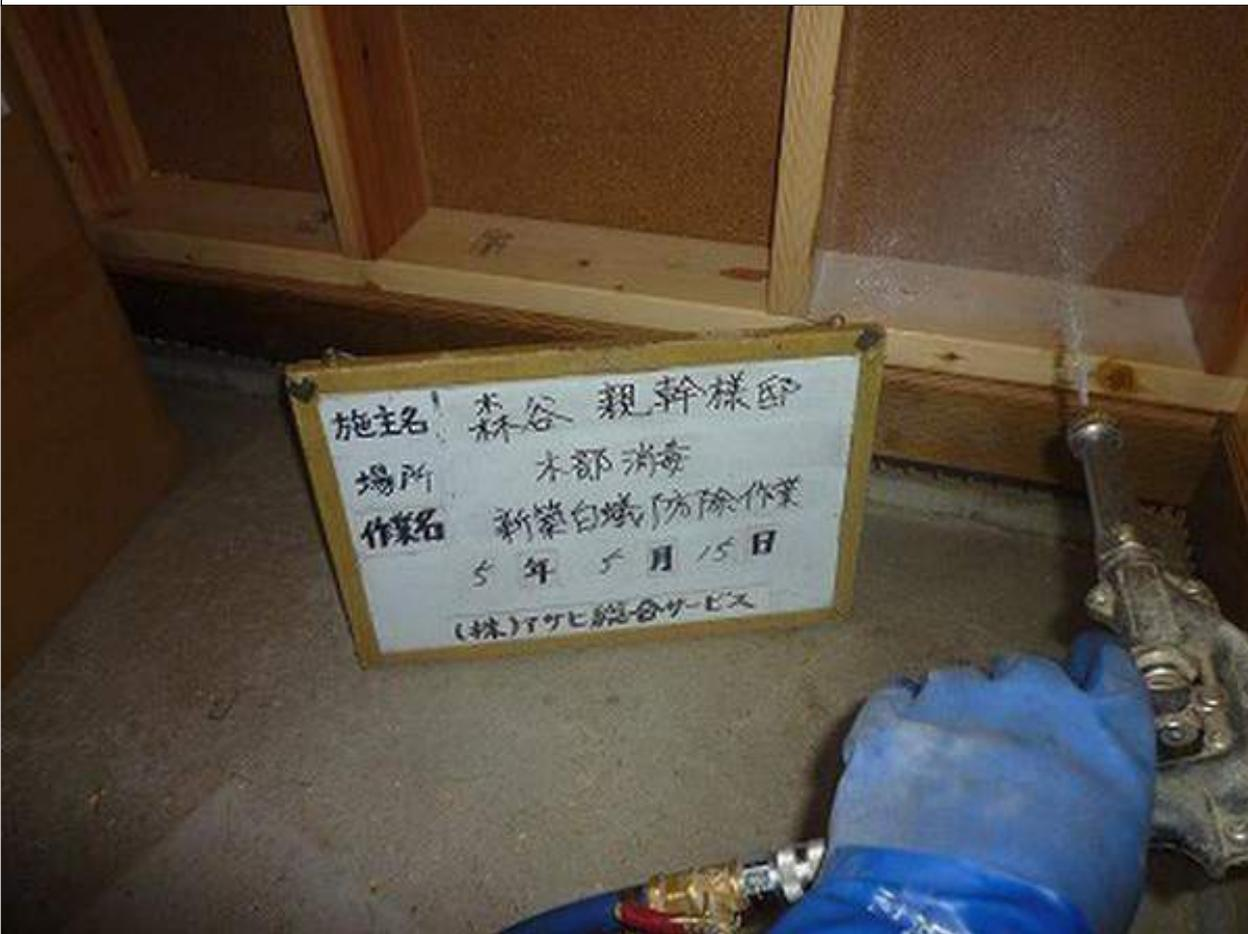
1-7口地面からの高さが1m以内の外壁の枠組の防腐・防蟻措置を現場で塗布・吹付をする。(3/4)
