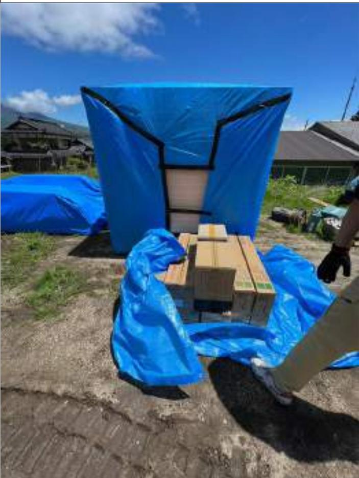
1-7口地面からの高さが1m以内の外壁の枠組の防腐・防蟻措置を現場で塗布・吹付をする。(1/4)
