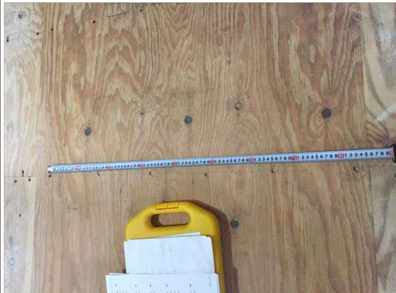
1-10口外壁下張りの釘のピッチはメーカー仕様の壁倍率通りに施工する。
