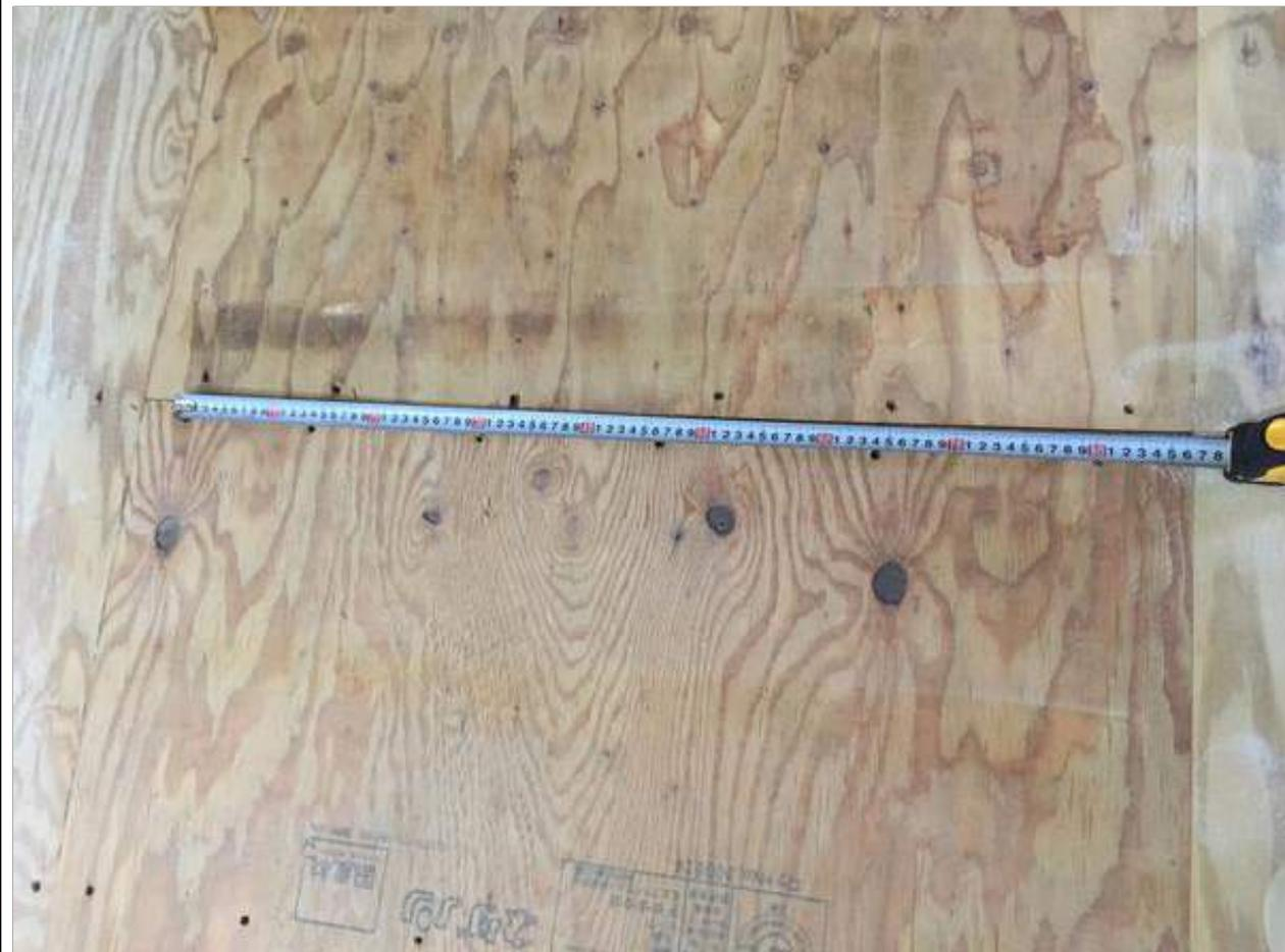
1-9口床下張材のくぎ打ちはCN50を周辺部150mm間隔以内、中間部200mm以内で平打ちする。床下張材の厚さが15mm以上の場合は、CN65が望ましい。(2/2)
