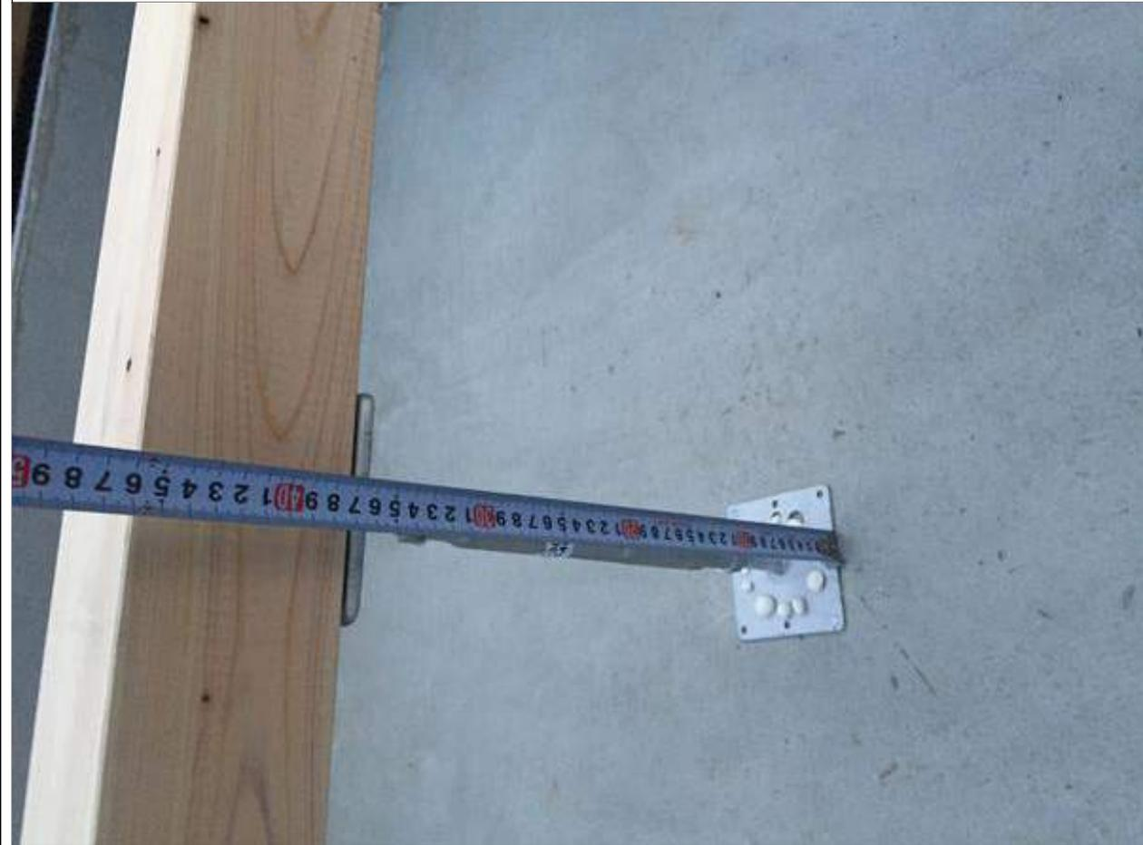
1-13 口接合金物の種類・施工位置が図面通りか確認する。(1/2)
